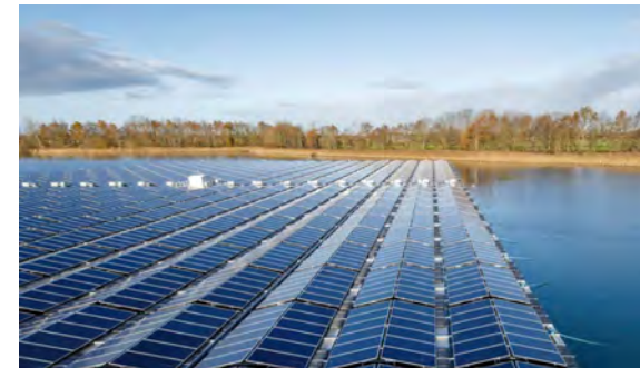
Tijdelijk afschakelen opwek
