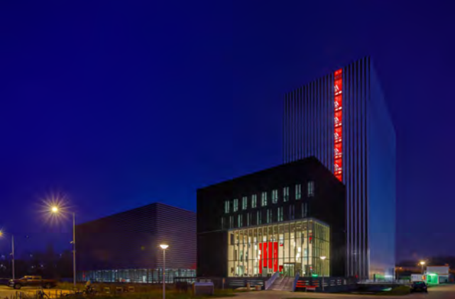
Elektrificatie bedrijven en industrie
